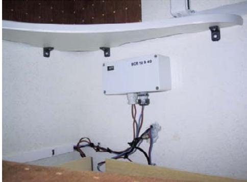
Das Gerät ist für den Solargenerator mit eine Leerlaufspannung von 25 V ausgelegt der Schwellwert ist auf 14,2 V eingestellt. Die Regelhysterese beträgt 0,3 V. Der max. zu erwartende Ladestrom von 3 A kann den 90 Ah-Akku nicht in die Gasung treiben und ist deshalb ideal zum Auffrischen und zu Ladeerhaltung des Akkus geeignet.
