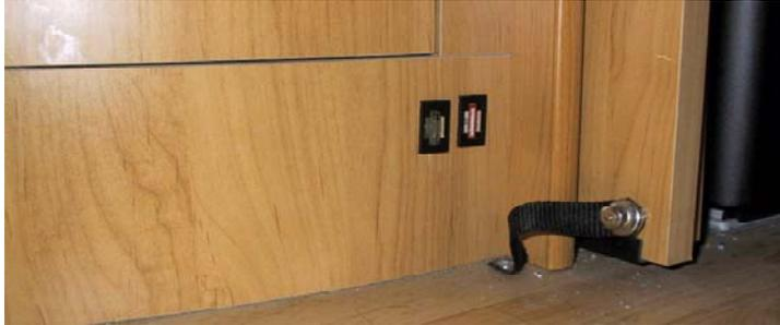
Die 25A und die 10A Sicherung wird gut zugänglich in herzustellende passende Ausschnitte mit Snap-in-Flachsicherungshalter (Conrad 535993-22) im Waschtisch montiert.
