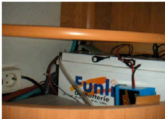
Die erwartete Lebensdauer mit angeschlossenerem Solargenerator, der im Winter die Funktion der Erhaltungsladung übernimmt, beträgt erfahrungsgemäß mindestens 5 Jahre. Das jetzt zusätzlich angeschlossene Megapulse Akku-Wartungssystem wird die Lebensdauer noch erhöhen.
