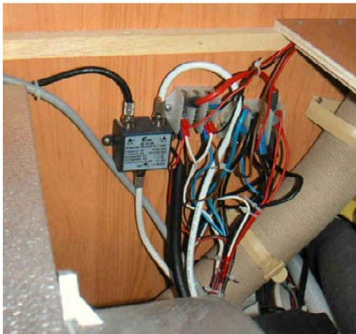
Die Verteilerleiste TB 2 ist im Kleiderschrank unterhalb der Abdeckung platziert, übernimmt die Funktion einer Zentralverteilung und stellt den Übergangspunkt zur Serienstromversorgung.
